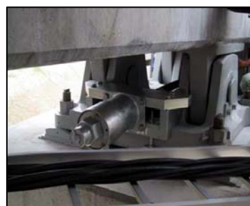
PC軌道桁落橋防止工事・・・PC軌道桁の支承（根もと）を連結し落橋を防止する。
