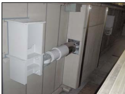
駅舎耐震補強工事・・・駅舎の主要構造物（支柱とホーム桁）をダンパー（振動吸収装置）で連結し、耐震性の向上を図る。
