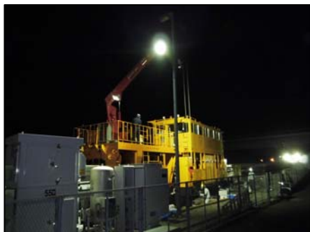
分岐器改修作業 (鉄道のポイントに相当)
